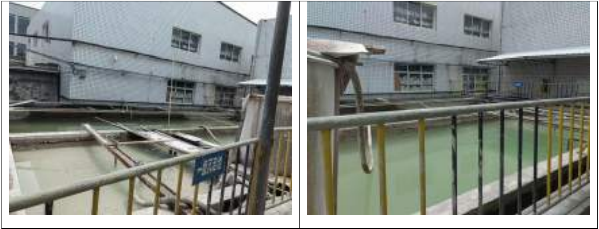
厂区综合污水处理站
